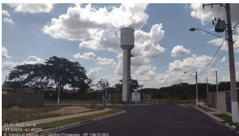
Figura 21: Reservatório Nova Primavera. Fonte: ENGTEC (2023).
