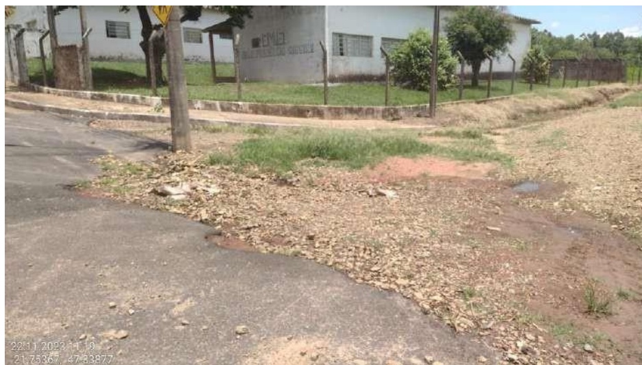
Figura 22: Rua sem calçamento que recebe enxurrada de via secundária.
