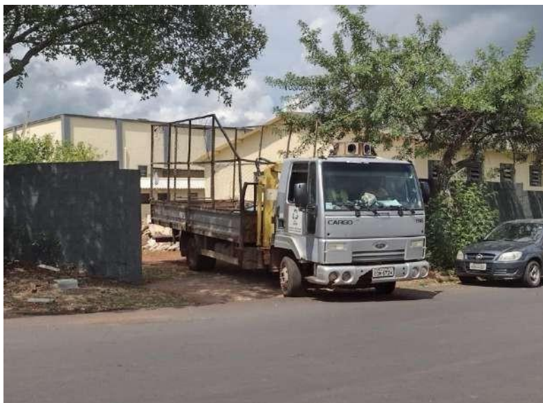
Figura 64: Fachada da AAESR. Fonte: ENGTEC (2023).
