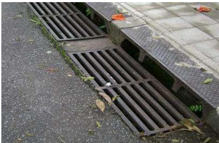
Figura 92: Boca de Lobo correta. Fonte: Drenagens Cidade (2023).
