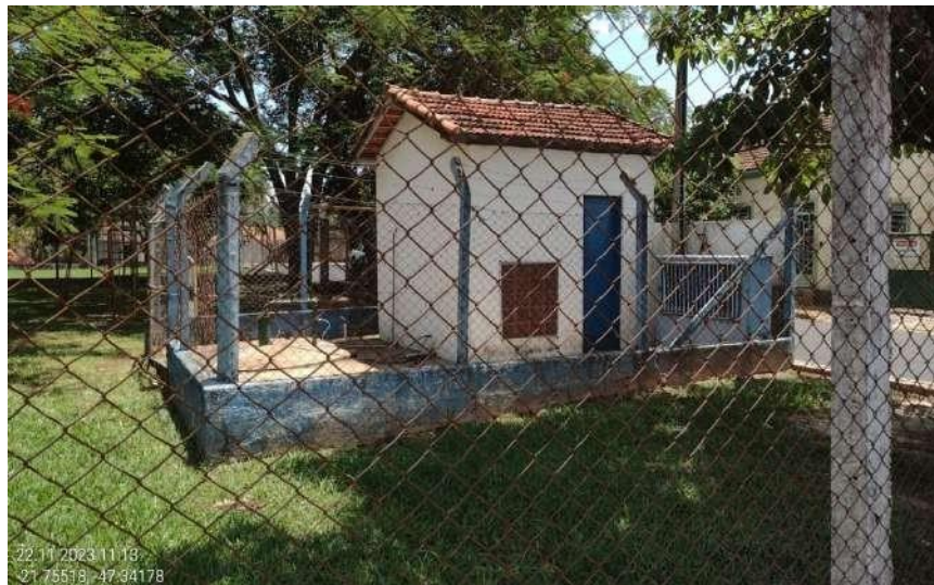
Figura 13: Captação Subterrânea (Poço Baixo) no Distrito Santa Cruz da Estrela. Fonte: ENGTEC (2023).
