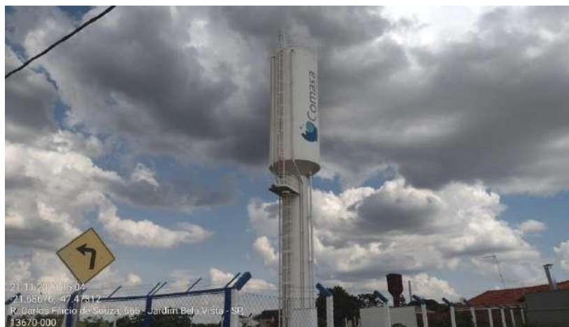
Figura 17: Reservatório Vila Poeta. Fonte: ENGTEC (2023).
