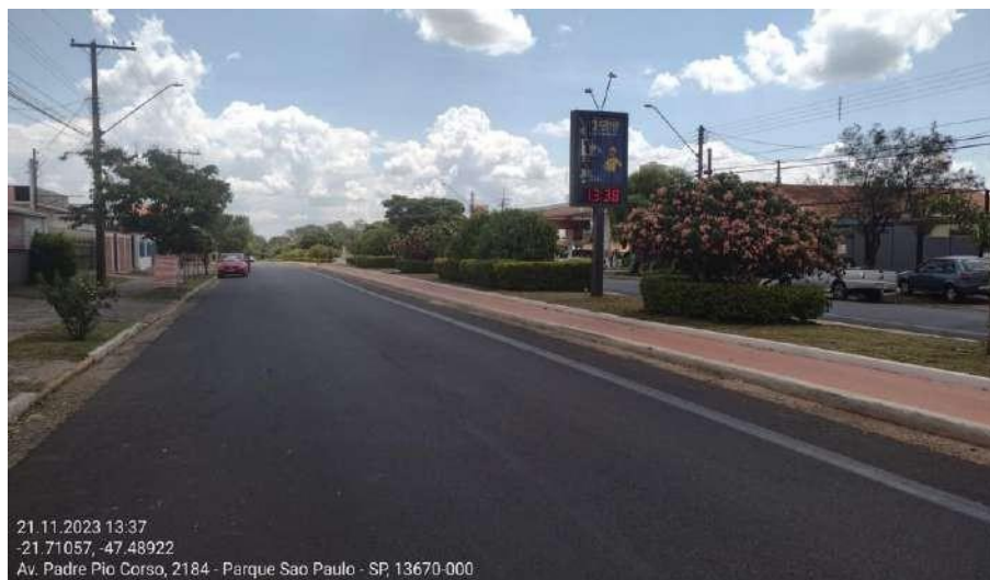
Figura 49: Rua Pavimentada com Asfalto em Santa Rita do Passa Quatro. Fonte: ENGTEC
