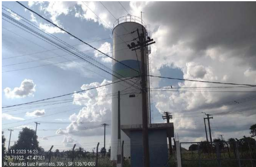
Figura 14: Reservatório Planalto na Rua Oswaldo Luiz Fantinato. Fonte: ENGTEC (2023).
