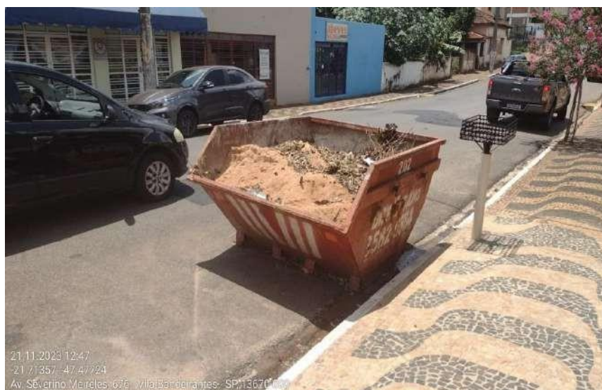
Figura 60: Caçamba de recolhimento de RCC. Fonte: ENGTEC (2023).
