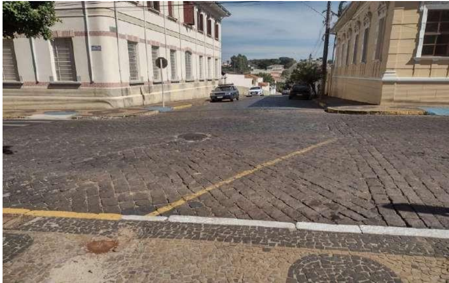
Figura 50: Rua Pavimentada com paralelepípedos. Fonte: ENGTEC
