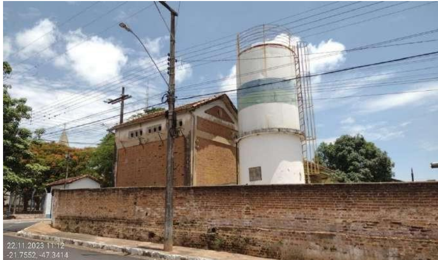
Figura 12: Reservatório localizado no Distrito Santa Cruz da Estrela. Fonte: ENGTEC (2023).
