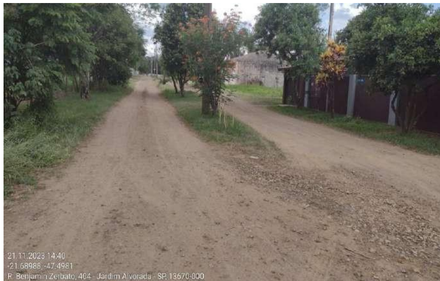
Figura 51: Rua não Pavimentada em Santa Rita do Passa Quatro. Fonte: ENGTEC
